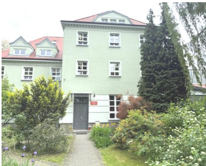
Budynek liceum po renowacji
